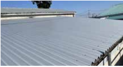
[ラップ工法]施工済の実際の屋根
