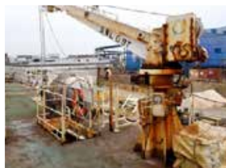
屋外クレーン
