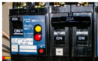
分電盤が見つからない
