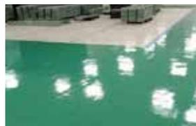
簡単な下処理程度で、油が浸透したコンクリート床でも**直接塗装**。**強力な密着力で耐久性も上がり**、タイヤ痕も付きにくくなりました。珪砂を入れて防滑効果も重ねました。
