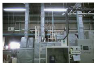
製品の乾燥不良が 生じる...
