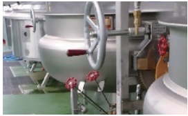
現場のタンクの補修
