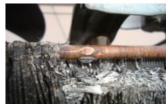
冷媒配管の 漏れ対策を行ないます!
