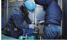
エア漏れ補修などエア配管メンテナンス
