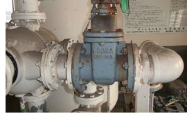
バルブ、減圧弁などの交換
