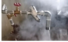
蒸気の漏れ対策など蒸気配管メンテナンス
