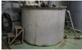
現場のタンクの腐食対策コーティング
