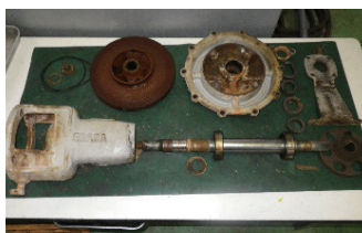
ポンプの分解整備 オーバーホール!
