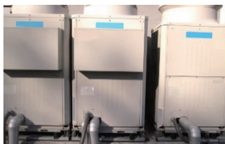
空調機器の部品交換 に対応します!
