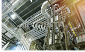
薬液などの特殊配管の修繕メンテナンス
