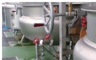
現場タンクの 補修を行います!
