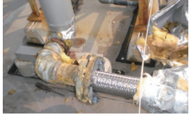
給排水管の腐食や詰まりの解消
